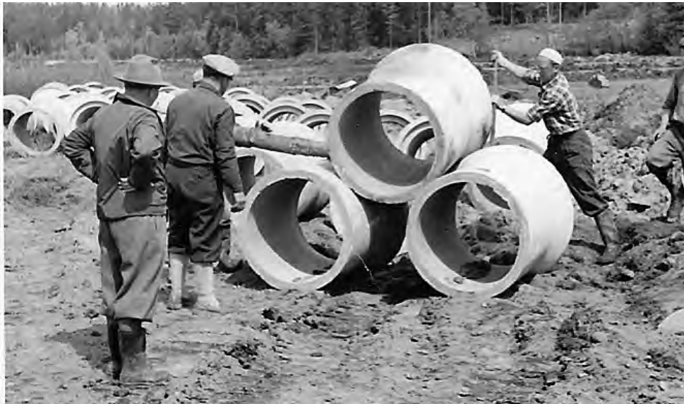
Det var nødvendig med store rørdimensjoner da Robergvannet skulle tappes 2-3 meter for å gi ny mark til golfbanen.
