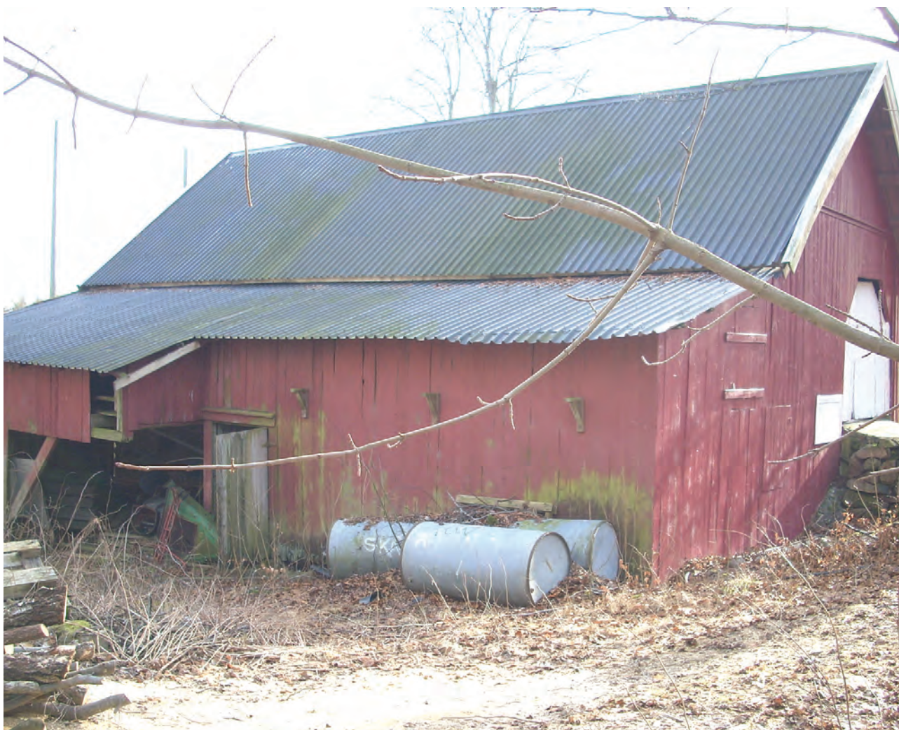
Skipsreder Harald Krohn-Hansen kjøpte Østre Roberg gård tidlig på 1960-tallet og ga gården til Vestfold GK. Gårdens låve ble brukt som nytt verkstedsbygg. Slik fortoner bygningen seg i dag. Låven er lokalisert like bak chipping-greenen på treningsfeltet.
